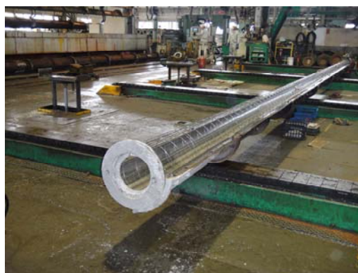
型枠にセットされたコン柱の鉄筋
