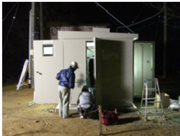
既設キュービクル増設作業
