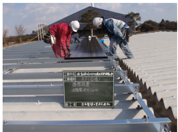
屋根へのモジュールの設置
