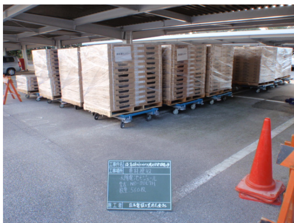
駐車場屋根下への仮置
