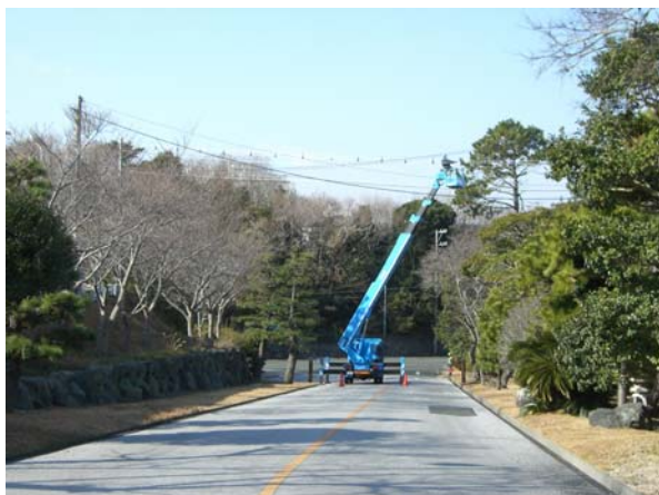
入り口道路の幹線横断作業
